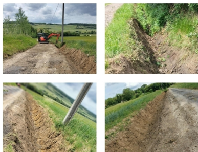
Réfection des fossés, chemin dit du chêne.
